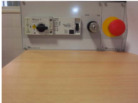
Figura 5. Protecciones en las mesas de trabajo: interruptor llave, interruptor diferencial y pulsador de parada de emergencia.
