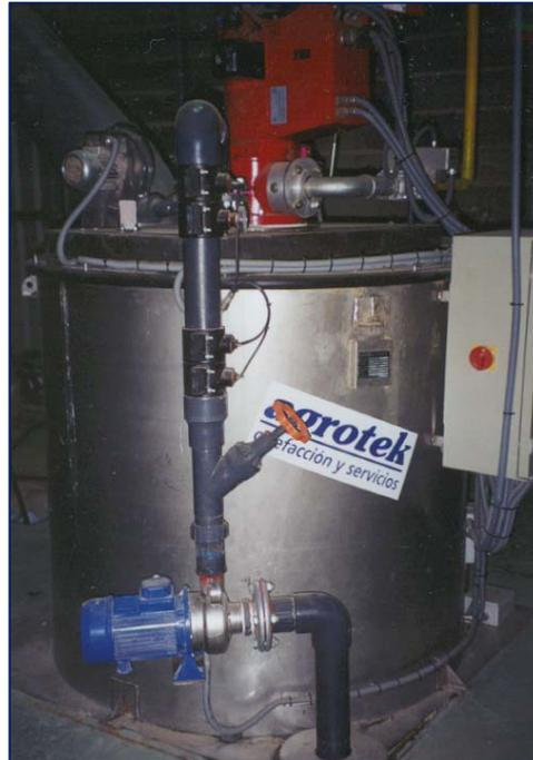
**Figura 51. Caldera vertical de un sistema de calefacción de agua caliente.**
