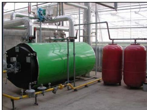
Figura 55. Instalación de calefacción con vasos de expansión de membrana.
