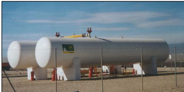
Figura 54. Depósitos de gas propano para una instalación de calefacción.
