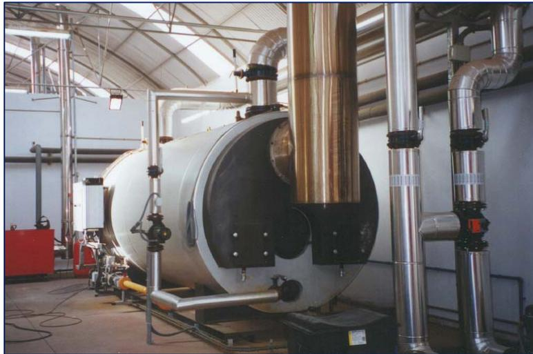
**Figura 50. Caldera pirotubular horizontal.**
