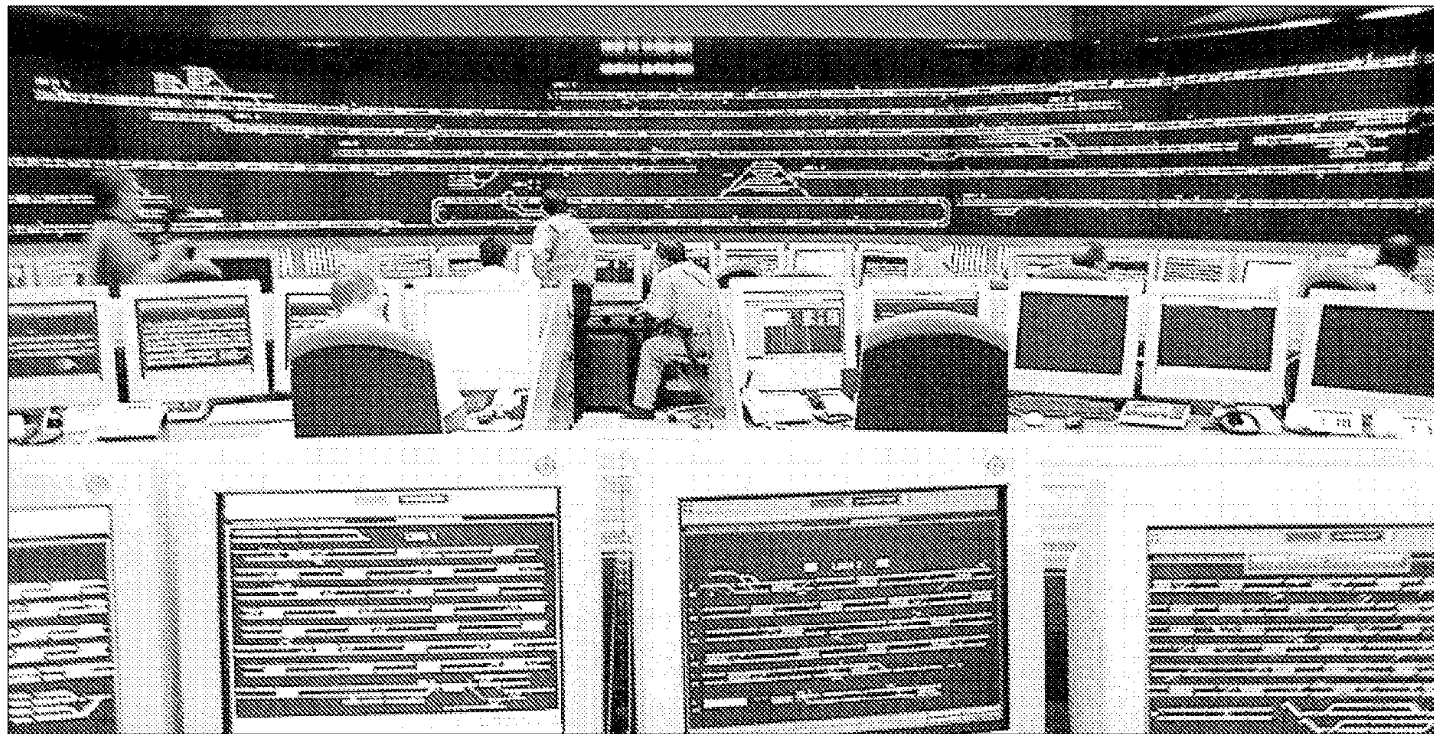
Centro de control del Metro de Madrid.
