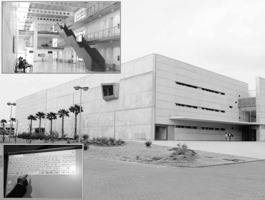
Varias imágenes del Aulario IV, una del exterior del edificio, otra del interior y la última un detalle de la pizarra digital
