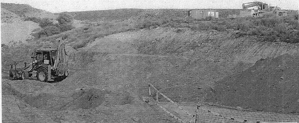
OBRAS. Estado de los trabajos de la rotonda que dará acceso al PITA. / J. J. MULLOR
