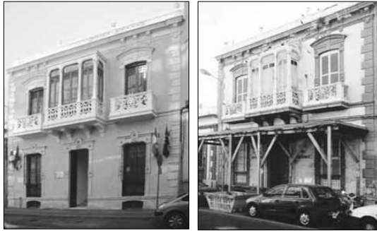
La Casa de Socorro ya restaurada, y la situación anterior
