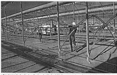
m Con el proyecto de estos investigadores los túneles del techo no se montan a cinco metros sino en el suelo.
