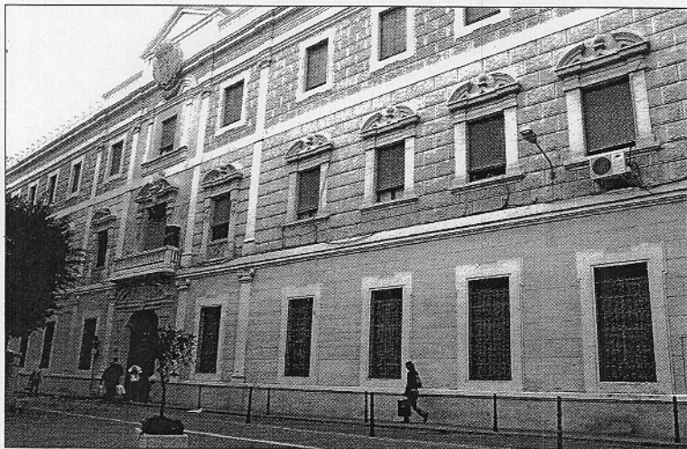
Imagen de la fachada principal del Cuartel de la Misericordia. / JAVIER ALONSO
