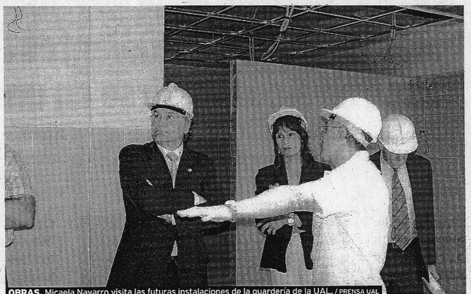
OBRAS. Micaela Navarro visita las futuras instalaciones de la guardería de la UAL. / PRENSA UAL
