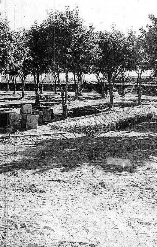
OBRA. Estado actual de las obras en el patio. / PRENSA UAL
