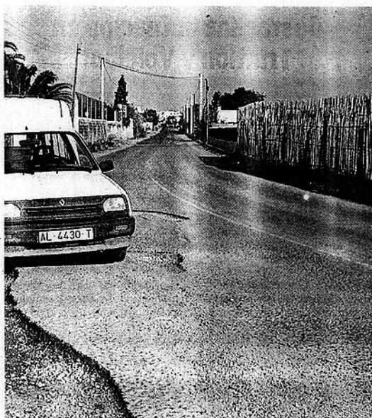
OBRA. Actuales accesos al Campus de La Cañada. / IDEAL
