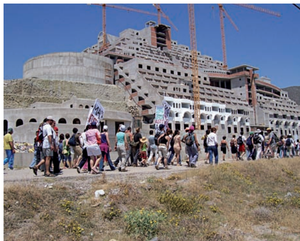
Construcción de un hotel en la playa del Algarrobico (Carboneras). Una mole de 21 plantas acaba con un espacio virgen, dentro de un espacio natural protegido, en un claro ejemplo de inobservancia y dejación administrativa. Año, 2006. Fuente: Felipe Ortiz Molina.
