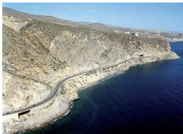
Dstrucción de paredes acantiladas en sierra de Gádor. Año, 2001. Fuente: SCA.
